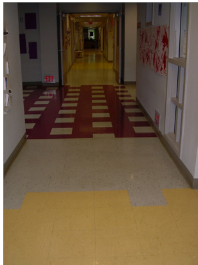
Figura 1: Chão de um corredor da Pennsylvania School for the Deaf. Fonte: Arquivo pessoal
