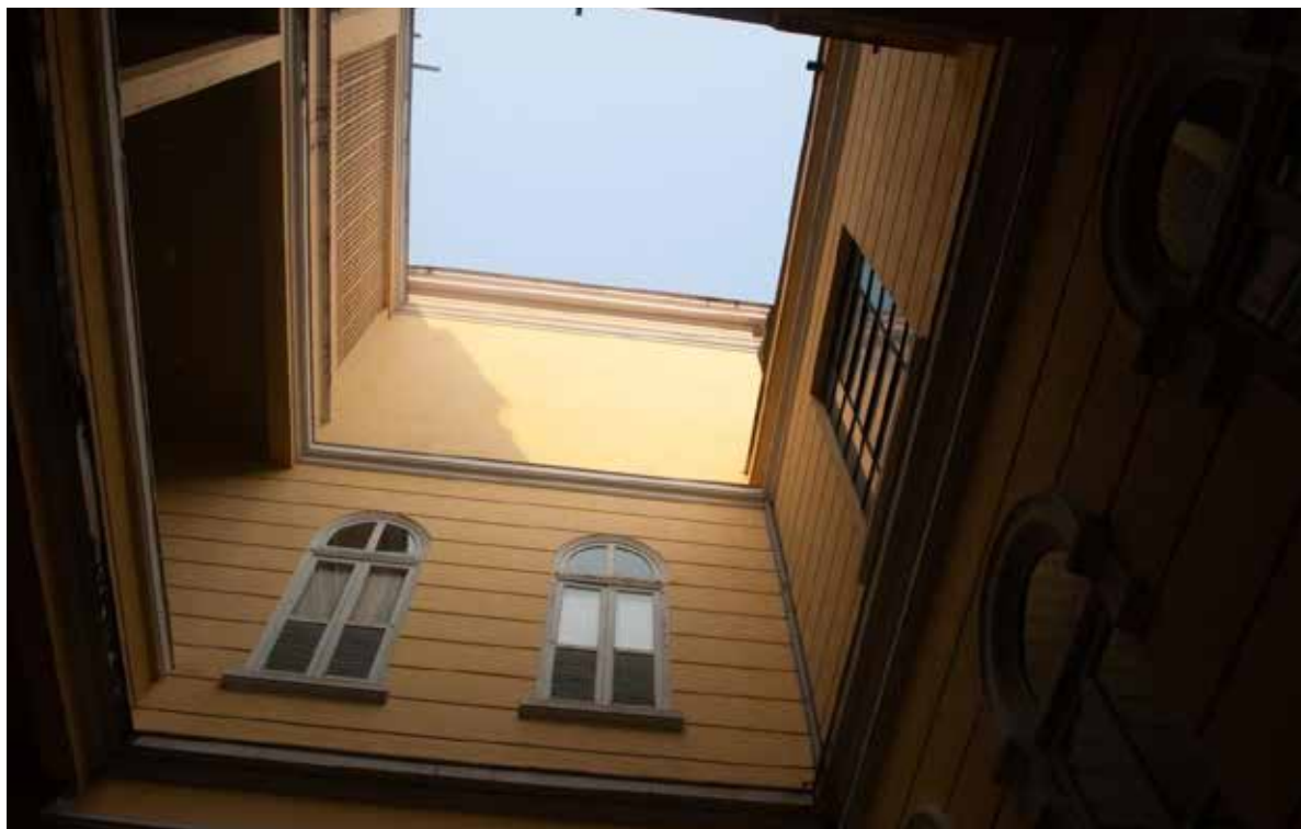
Imagem 1. Pátio central do edifício histórico. 2025. Fotografia digital.
