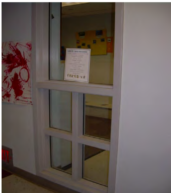
Figura 7: Janela de corredor da PSD.
