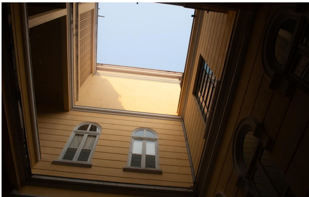
Imagem 1. Pátio central do edifício histórico. 2025. Fotografia digital.
